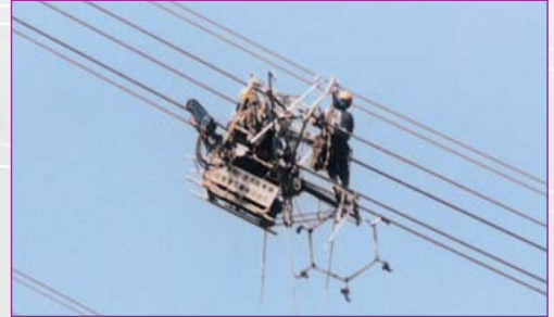
自走式FA-E8168を使用して6導体用スパーサの取付作業中
